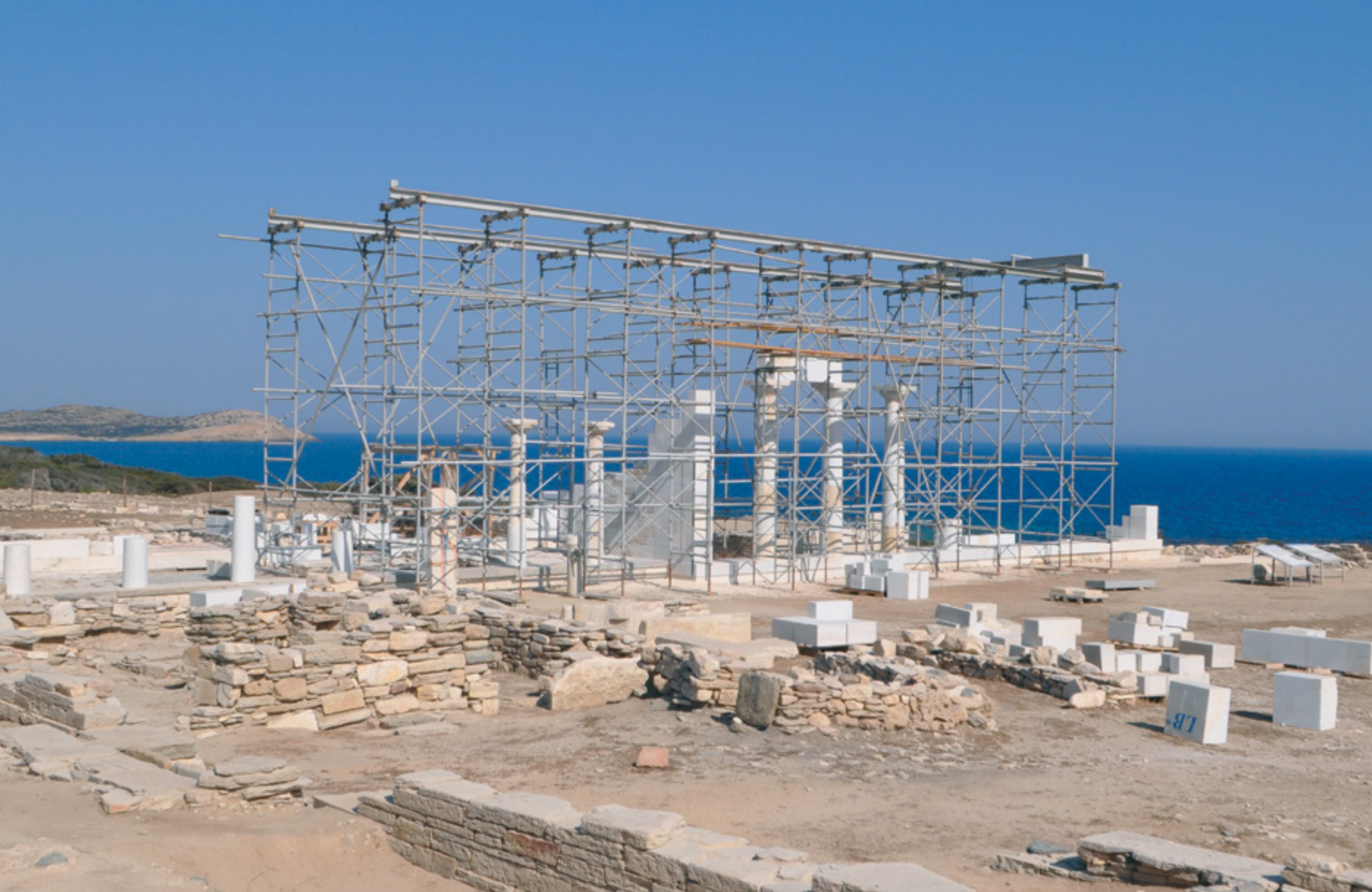
Οι αναστηλωτικές εργασίες στο ιερό του Απόλλωνα στη θέση Μάντρα του Δεσποτικού διήρκησαν 4 εβδομάδες.
