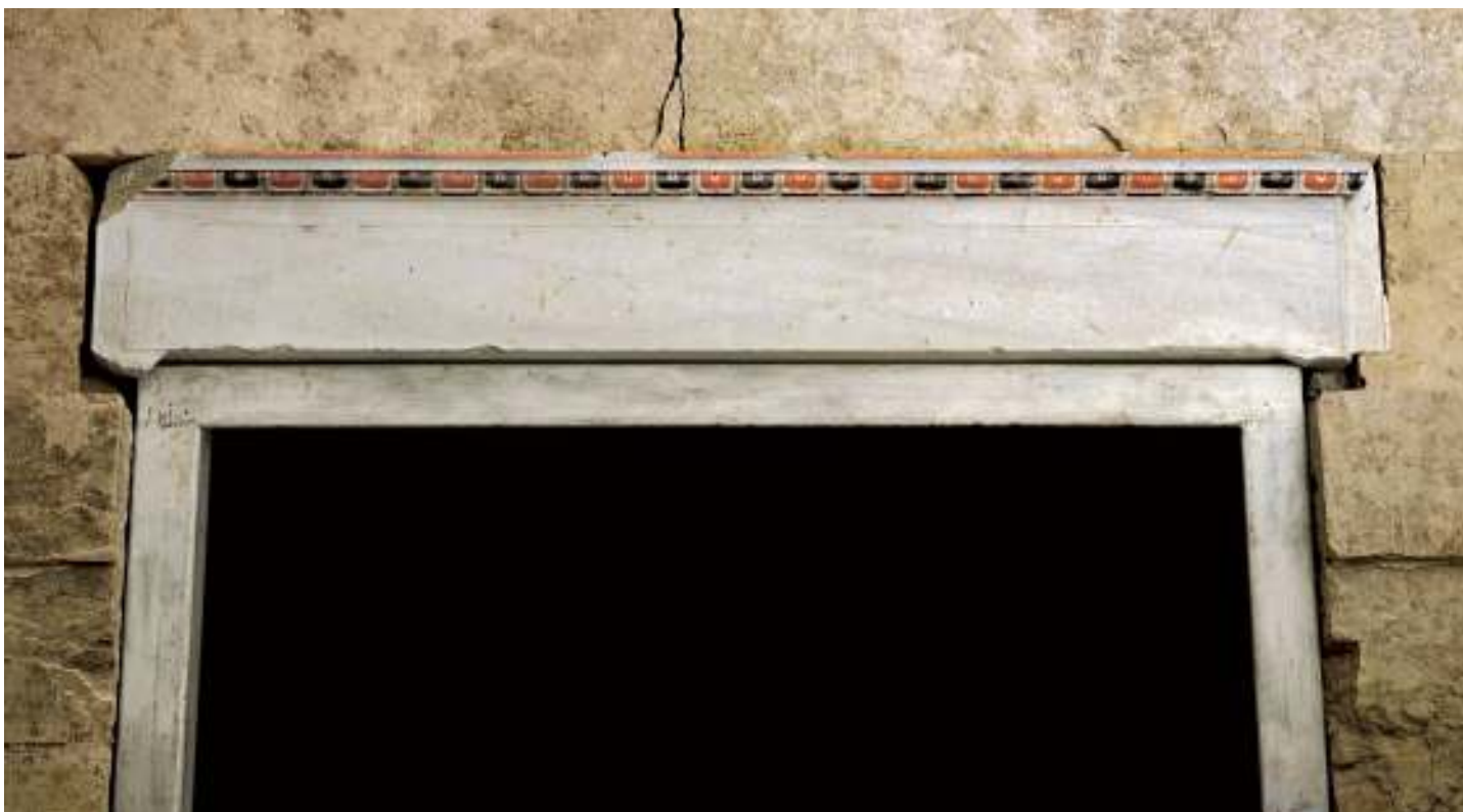
Μακεδονικός τάφος Δ' με τις επιγραφές: Το μαρμάρινο ανώφλι του θυρώματος του θαλάμου του, υποστηριζόμενο από σύγχρονη σιδερένια κοιλοδοκό. Μετά το 322 π.Χ.
